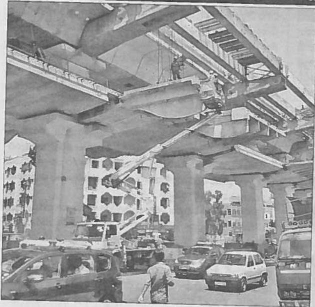
మెట్టుగూడలో కొనసాగుతున్న మెట్రో స్టేషన్ నిర్మాణ పనులు
